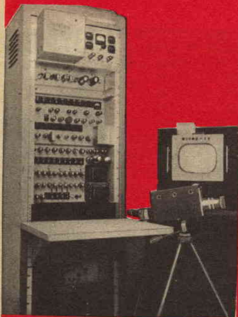
Il trasmettore costruito da Arnold Proner, ingegnere presso la NBC, comprende un amplificatore-trasmettitore, una camera vidicon e un apparecchio di controllo. La maggior parte delle apparecchiature è simile ai primi apparati TV commerciali.
